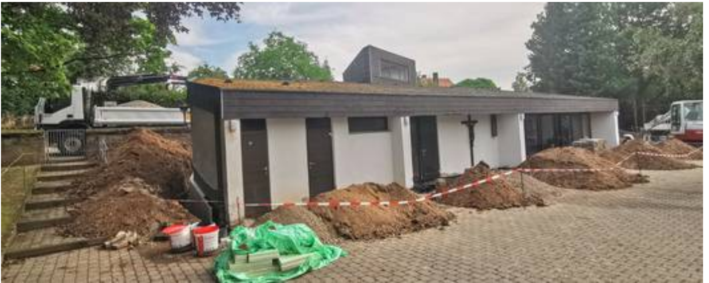
Abb.: Baustelle Aussegnungshalle
